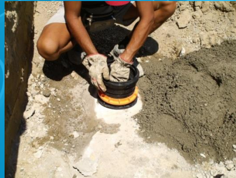
FASE 1: Esecuzione della foratura su un tubo Ø800 di calcestruzzo
