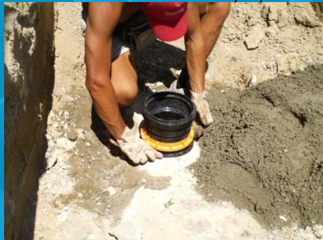
FASE 3: Serraggio della clip con chiave in dotazione
