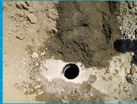
FASE 1: Esecuzione della foratura su un tubo Ø800 di calcestruzzo
