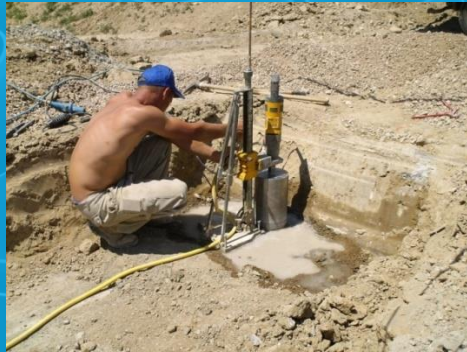
FASE 1: Esecuzione della foratura su un tubo Ø800 di calcestruzzo
